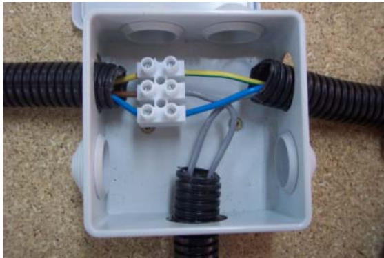
Detalle de conexión del pulsador
